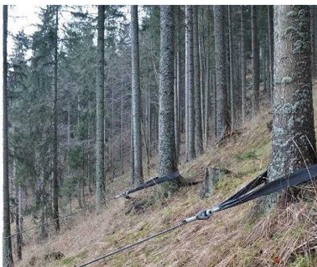
Na fotografiji sta vidni dve sidrišči (od skupno štirih) stolpa žičnice.
