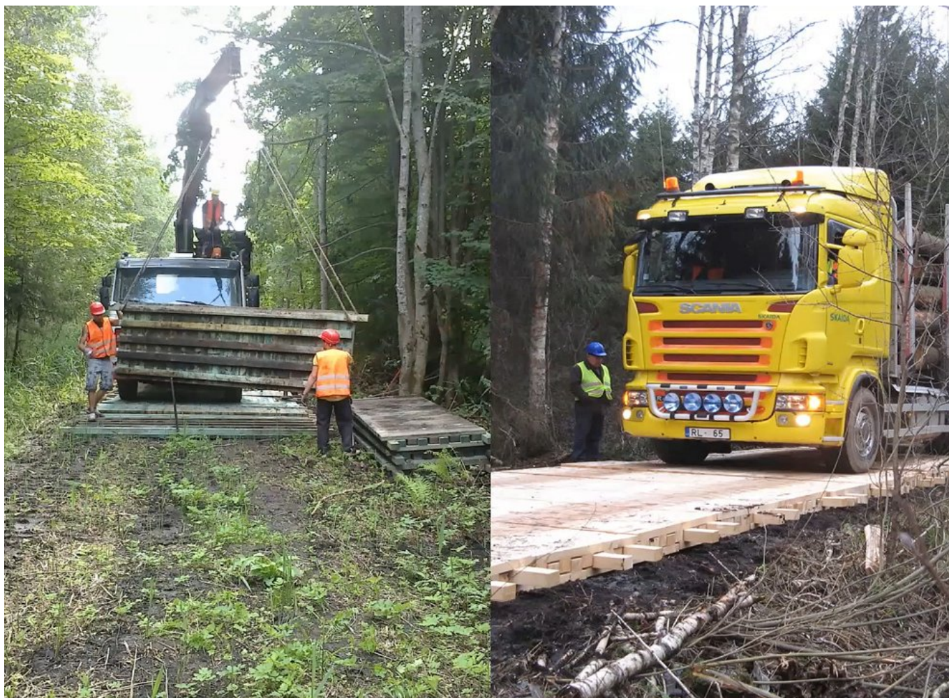
Slika 2: Postavitev (levo) in uporaba (desno) začasne lesene gozdne ceste v Latviji (Abizare, 2021)
