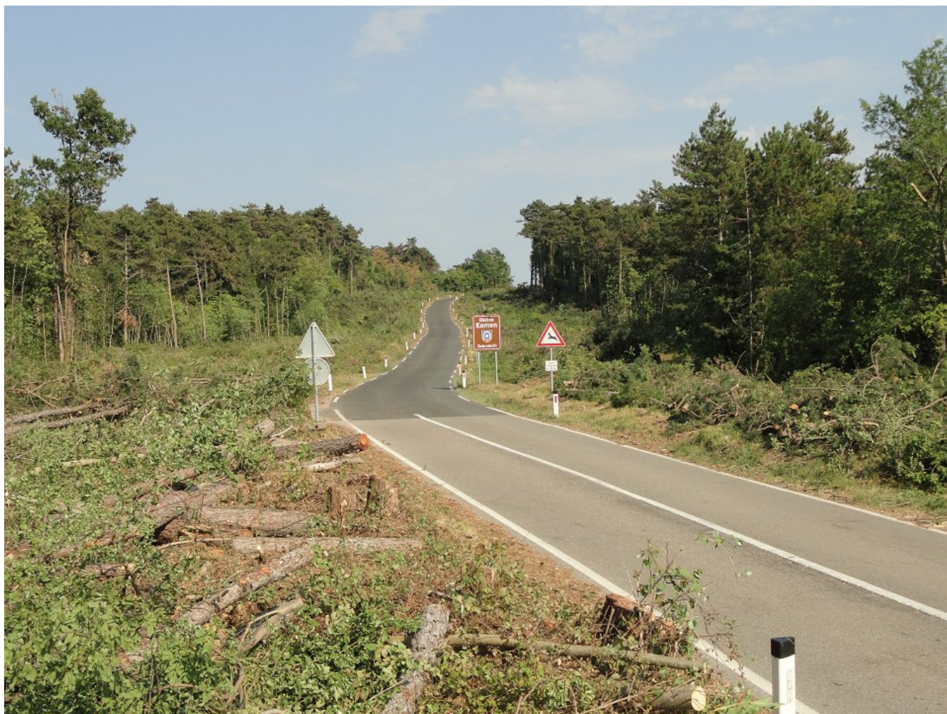
Slika 3: Izvedena preseka na cestnem odseku Vojščica – Zagrajec
