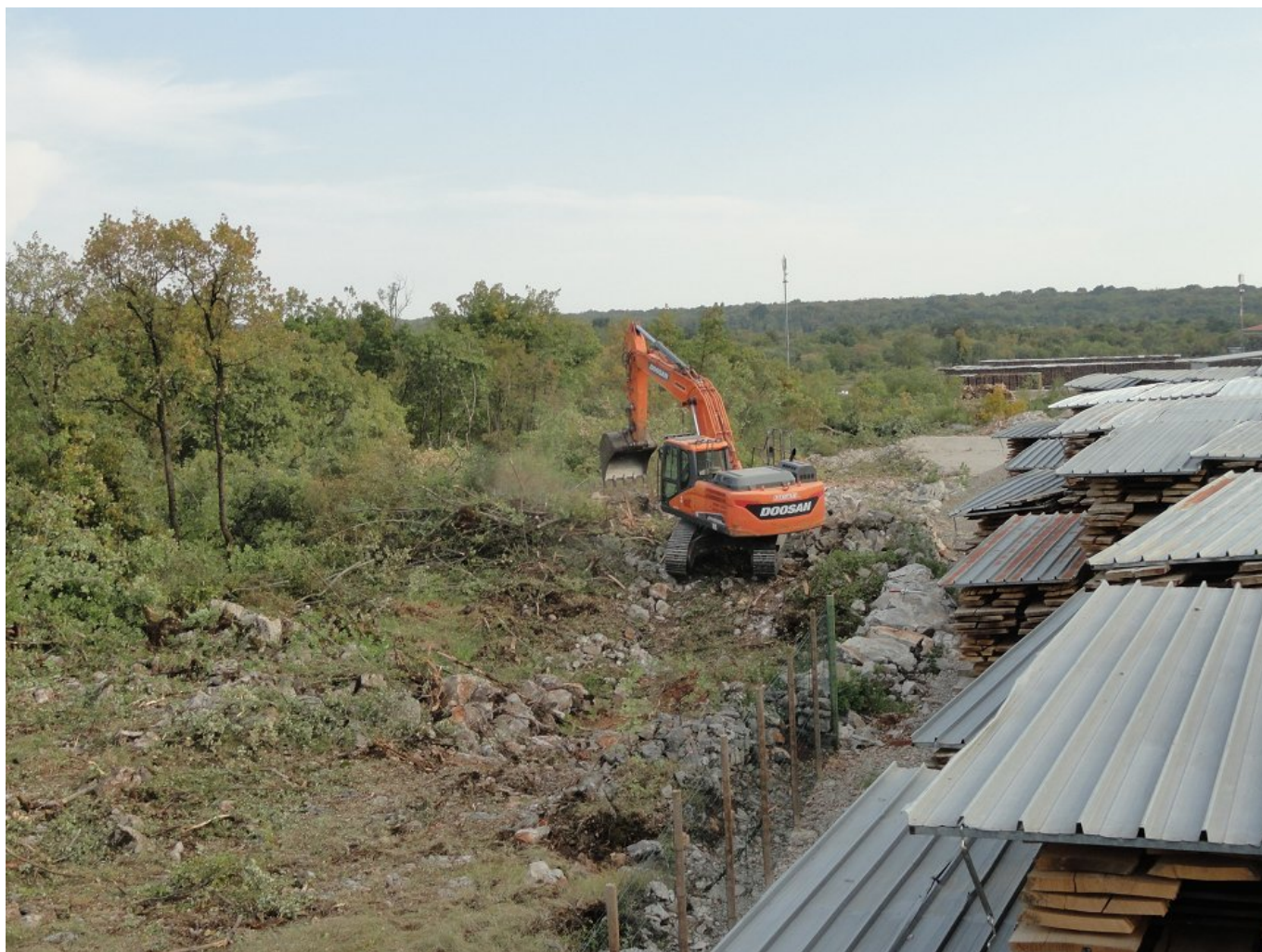
Slika 2: Izvajanje preseke z bagerjem okoli podjetja Marušič d.o.o., kjer so skladiščene velike količine bukovih desk.
