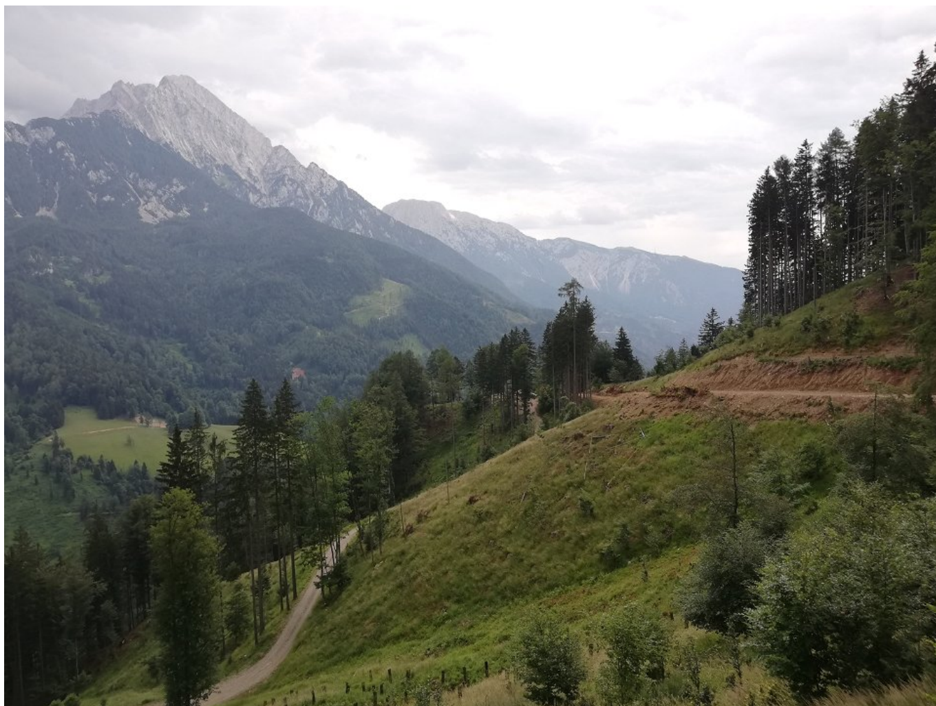
Slika 3: gradbena dela na drugem kraku povezovalne ceste tudi dobro napredujejo
