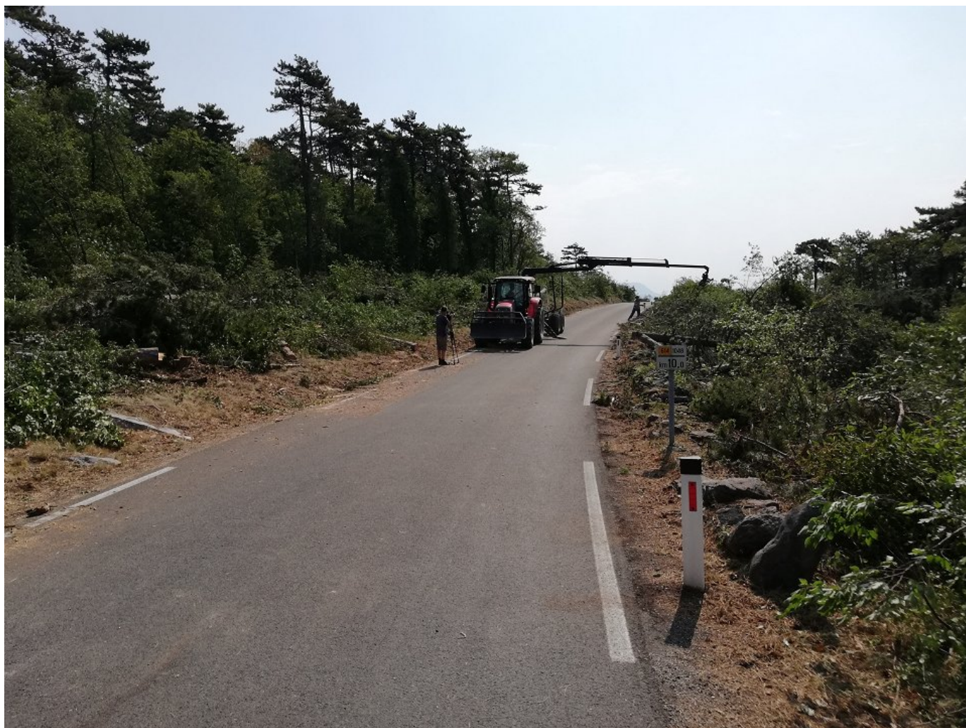
Slika 5: Med interventnim posekom je traktor z gozdarsko prikolico služil predvsem pomoči sekačem med sečnjo in odstranitvi GLS s cestnega telesa. Pred traktorjem je predstavnik tuje medijske hiše, ki je delo budno spremljal.
