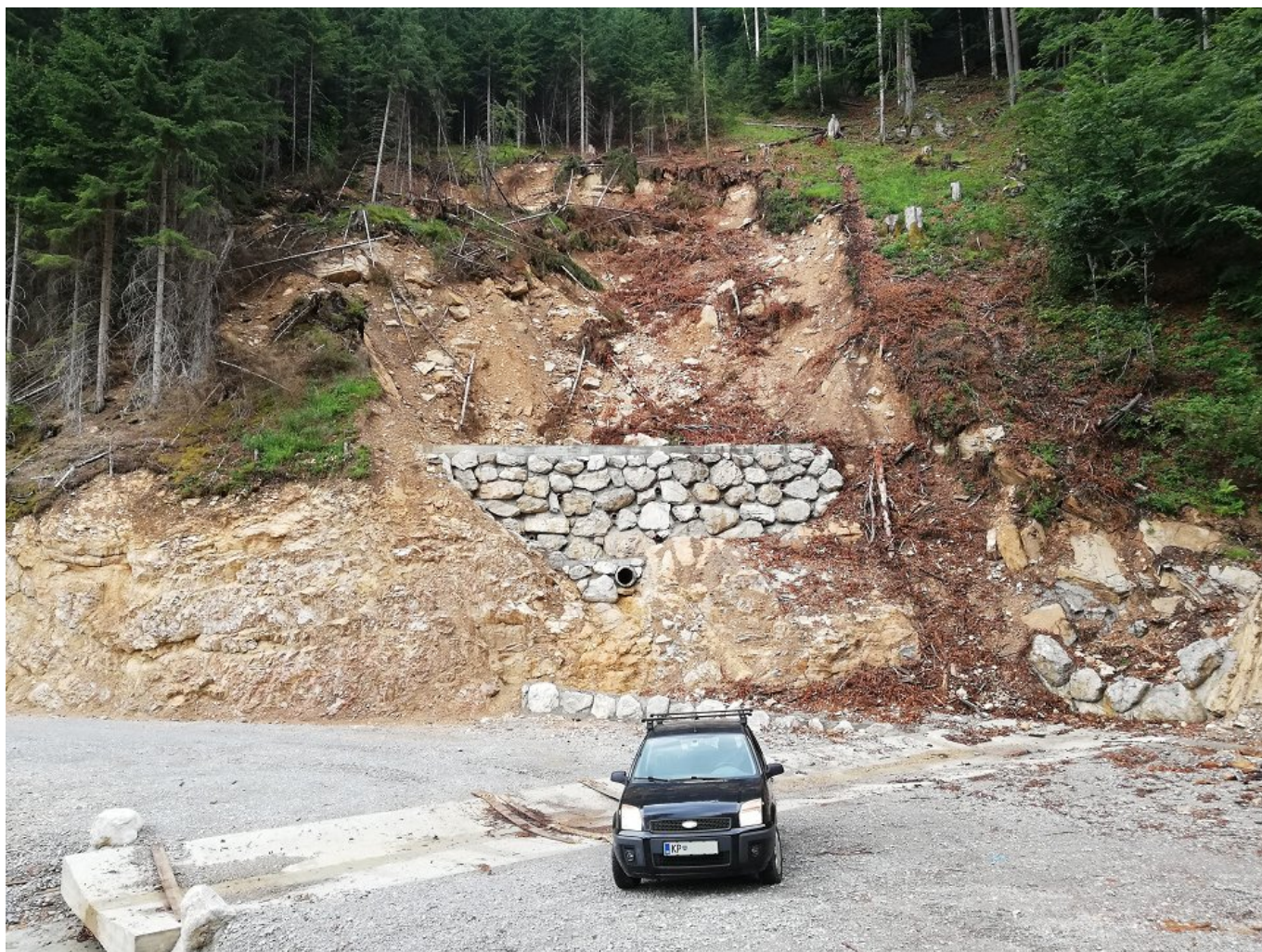
Slika 2: sanacija plazu in mulda
