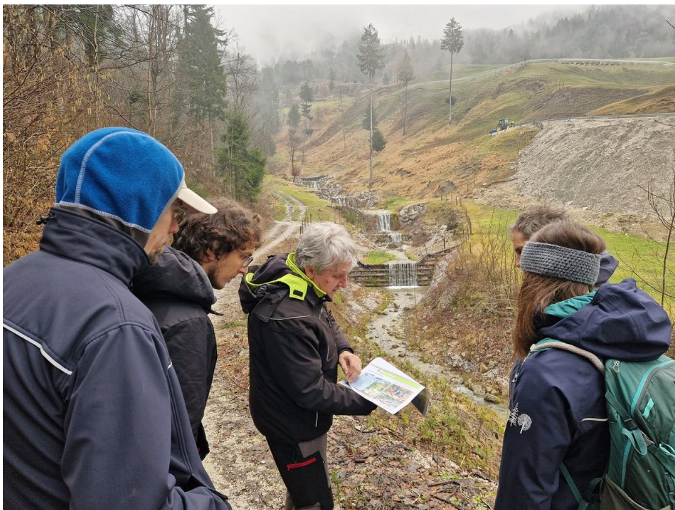
Naslovna slika: ogled sistema ustalitvenih pregrad in kranjske stene na hudourniku Blatnica pri kmetiji Klemenčevo (Foto: Urša Vilhar)
