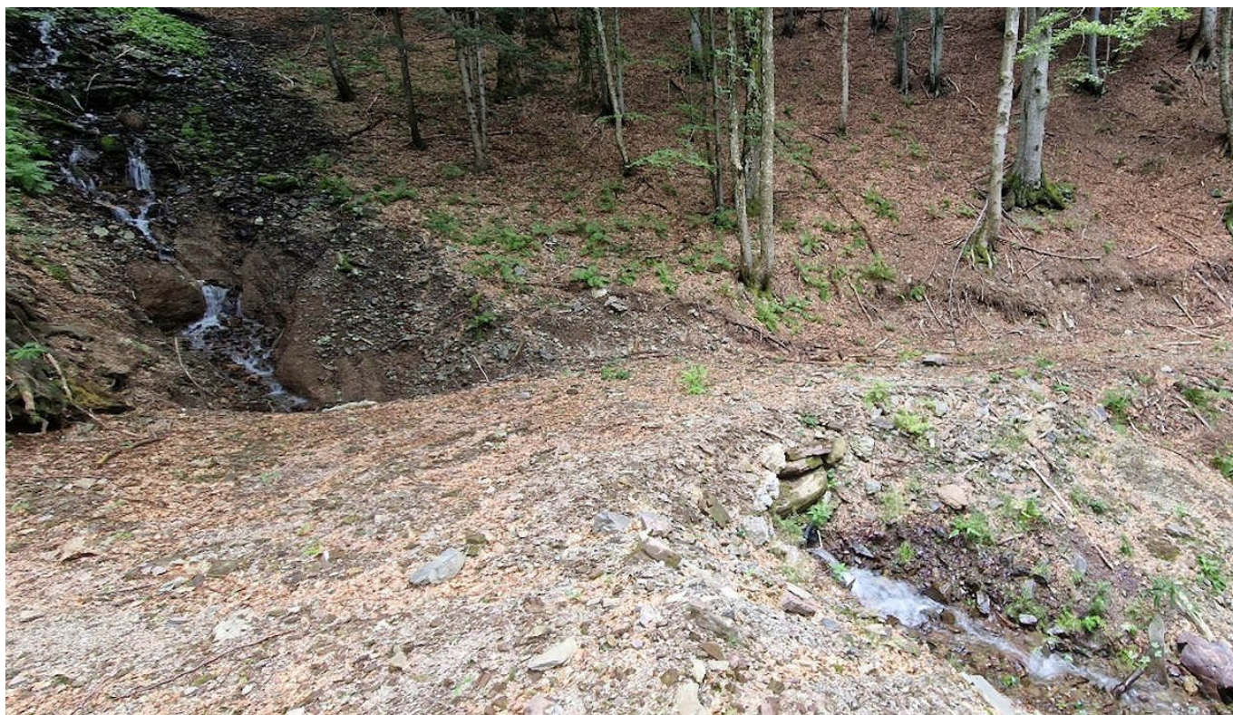
Slika 4: Gozdna vlaka s cevnim prepustom, ki kljub ekstremnemu padavinskemu dogodku ni utrpela škode (Foto: Urša Vilhar)
