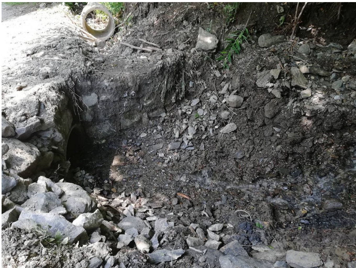
Slika 1: Sveže očiščen cevni prepust (Foto: Jaša Saražin)
