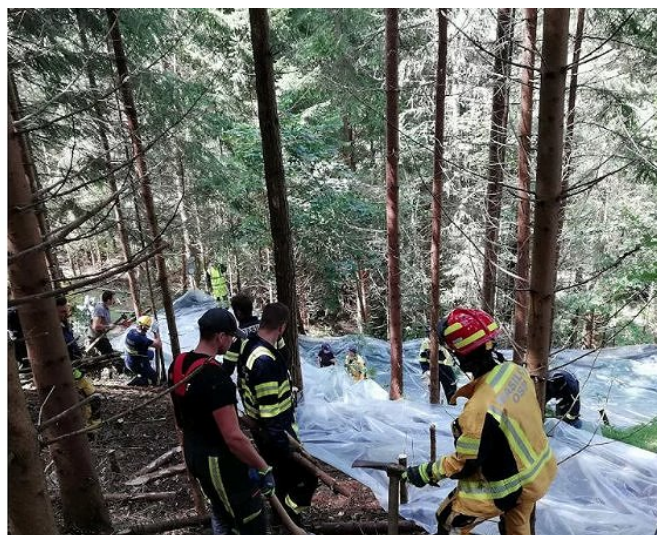
Slika 10: Kljub obilici intervencij v samih naseljih, so interventne službe izvajale nujne ukrepe tudi v gozdnem prostoru. Koroški gasilci so s pomočjo gasilcev Obalne gasilske zveze Koper izvedli prekrivanje razpoke nad več kot hektar velikemu zemeljskem plazju, ki je ogrožal stanovanjske objekte v Črni na Koroškem.
